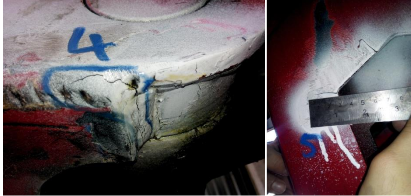
Resim 10-Mobil vinçlerde bulunan çatlaklar
