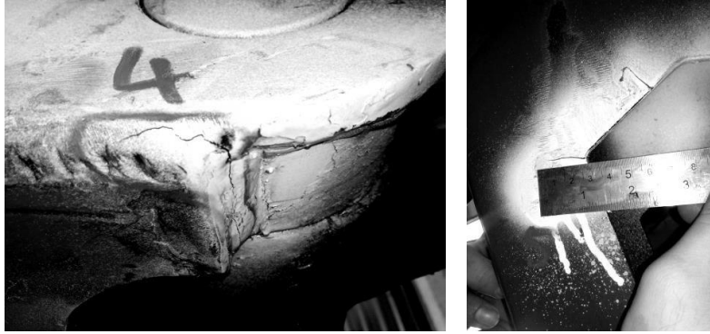
Resim 10. Mobil vinçlerde bulunan çatlaklar
