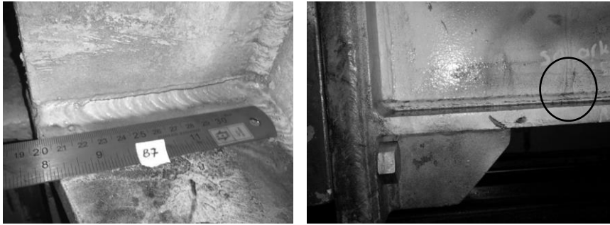
Resim 8. Köprülü vinçlerde bulunan çatlaklar
