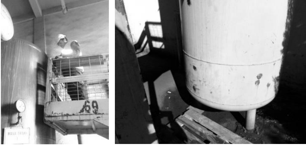
Resim 11. Hava tanklarının kontrolleri ve korozyonlanma
