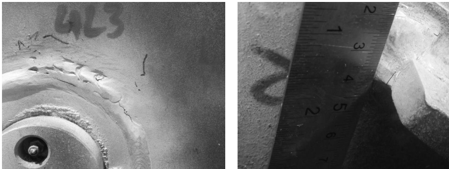
Resim 7. Beton pompası kontrolünde bulunan çatlaklar
