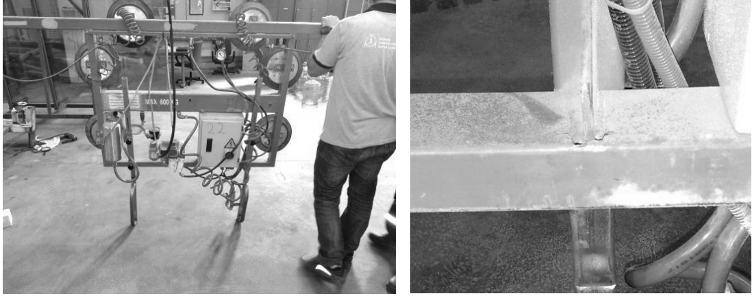
Resim 13. Özel üretim konstrüksiyonda bulunan çatlaklar
