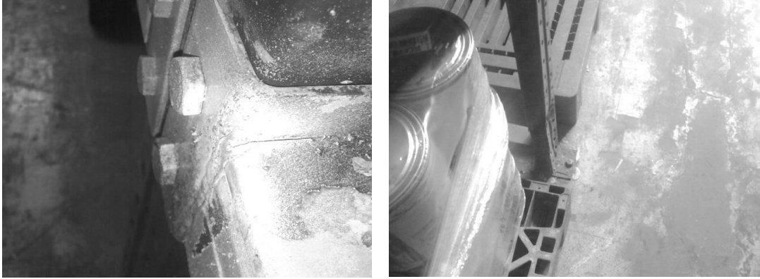
Resim 12. Rafların kontrollerinde bulunan çatlaklar ve plastik deformasyonlar
