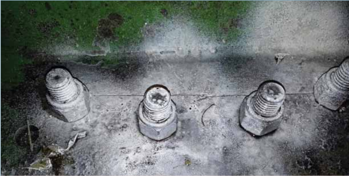
Fotoğraf 5. Tahribatsız Muayene Personeli Tarafından Konstrüksiyonda Bulunan Çatlak
