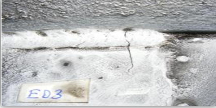
Şekil 2. Konstrüksiyonda Bulunan Yorulma Çatlağı
