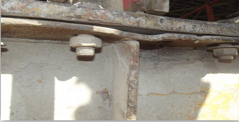
Şekil 7. Gözle Muayene Sonucunda Tespit Edilen Plastik Deformasyon ve Çatlak
