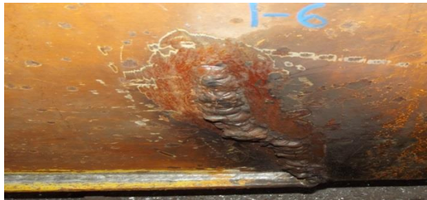
Resim 5. Uygun Yapılmayan Tadilat Sonrasında Tekrar Oluşan Çatlak
