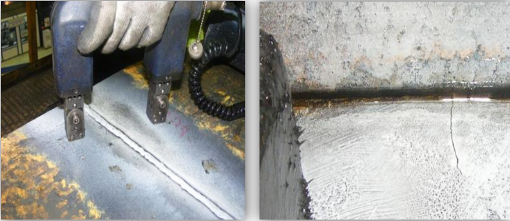
Şekil 6. Konstrüksiyona Uygulanan Tahribatsız Muayene Sonucunda Bulunan Çatlak
