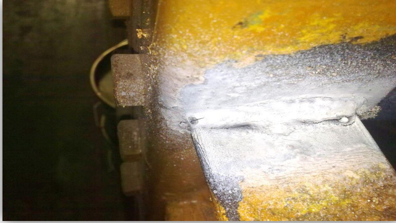
Şekil 9. Rafın Yorulma Kontrolü Esnasında Manyetik Parçacık Testi İle Tespit Edilen Çatlak
