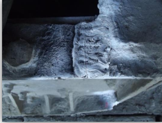
Şekil 11. Manyetik Parçacık Testi Sonucunda Elde Edilen Bulgu-Çatlak
