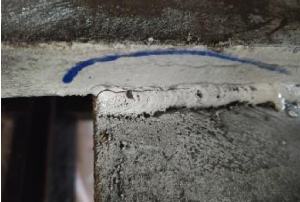
Şekil 3-Manyetik parçacık muayenesi sonucunda işletme aşamasında bulunan çatlağı
