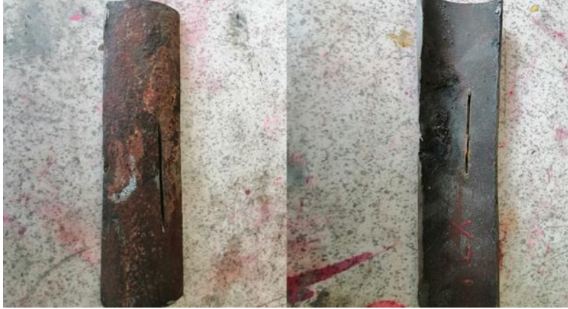
Şekil 12-Yapılan kalınlık ölçümü sonrası korozyon durumu tespit edilen bir basınçlı boru hattı numunesi
