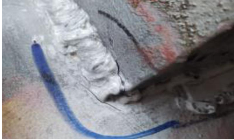
Şekil 10-Köprülü vincin tahribatsız muayenesinde bulunan çatlak (Haz Bölgesi)
