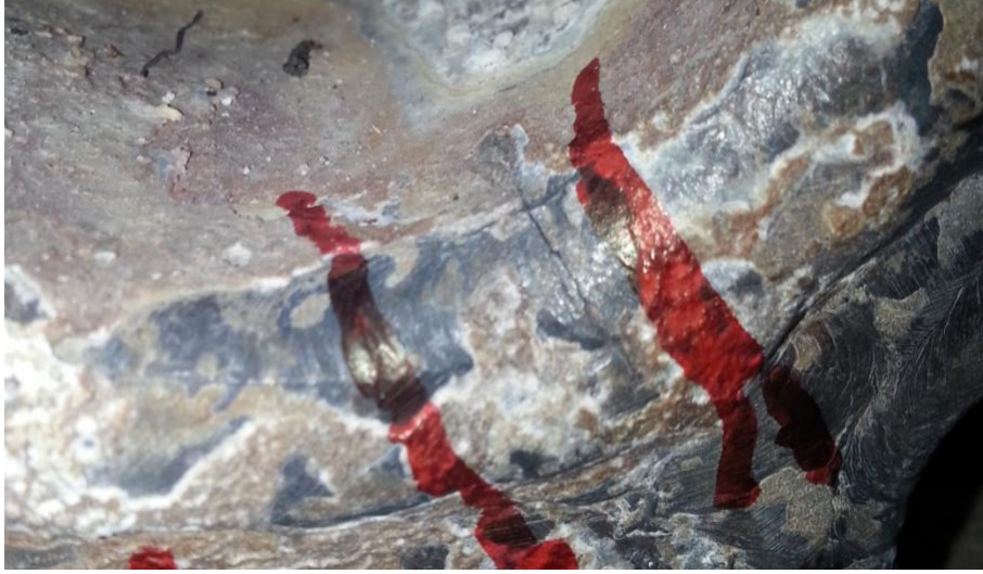
Şekil 11-Buhar kazanında tespit edilen çatlak
