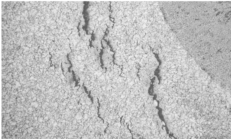
Şekil 9-İşletme aşamasında kullanılan malzemenin replika testi sonucu keşfedilen mikro çatlaklar[6]
